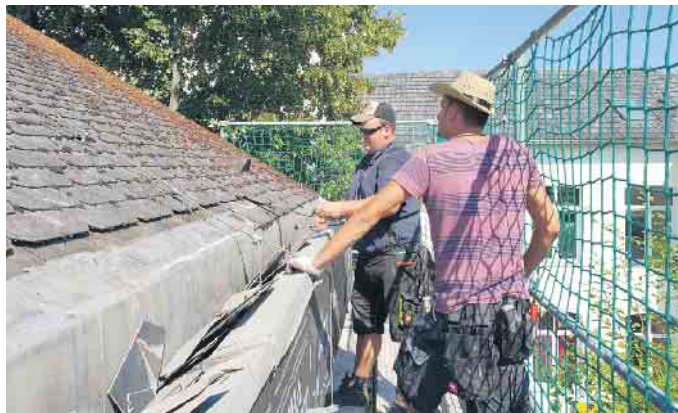
Verklammerung und Befestigung der Dachziegel bzw. -platten werden beim DachCheck geprüft. Foto: ZVDH/akz-o
