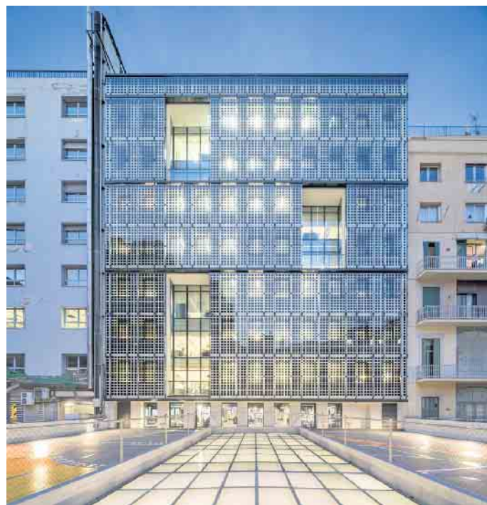
Gut für Klimabilanz und Energieausbeute: Eine vorgehängte BIPV-Lösung an der Fassade einer Gewerbeimmobilie. Copyright: AGC Glass Europe
