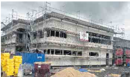
Der Rohbau des Sozialgebäudes ist abgeschlossen, vor dem Winter sollen die Fenster eingebaut werden.
