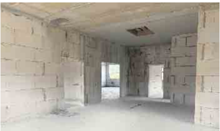
Im Obergeschoss werden noch weitere Trockenbauwände eingezogen, links ist der Eingang zur Kleiderkammer und zum Schulungsraum zu erkennen.
