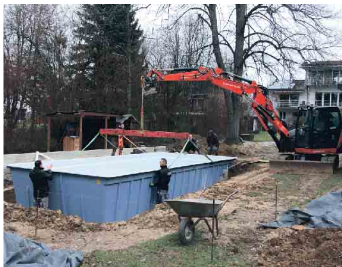
Teamwork auf der Baustelle. Foto: Schwimmbad Henne/akz-o
