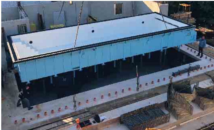
Poolbau mit Präzision. Foto: Schwimmbad Henne/akz-o
