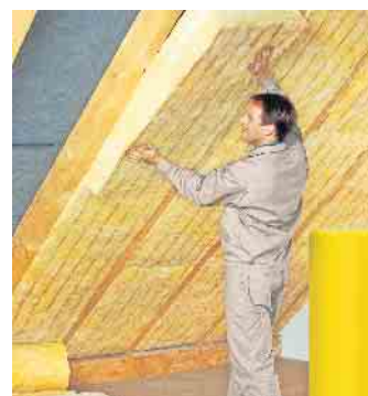
Die meiste Energie bei Ein- und Zweifamilienhäusern geht über das Dach verloren. Eine Dämmung mit Mineralwolle etwa kann je nach baulichem und energetischem Zustand den Heizwärmebedarf um bis zu 35 Prozent senken. Foto: djd/www.der-daemmstoff.de
