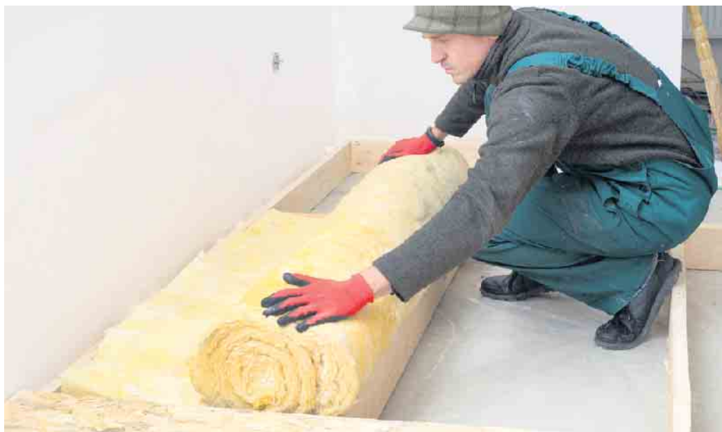
Eine Dämmung aus Mineralwolle senkt den Energieverbrauch und die damit verbundenen Kosten eines Gebäudes bei gleichzeitig verbessertem Schall- und Brandschutz. Einfache Maßnahmen können in Eigenregie durchgeführt werden. Foto: djd/www.der-daemmstoff.de/Smole - stock.adobe.com
