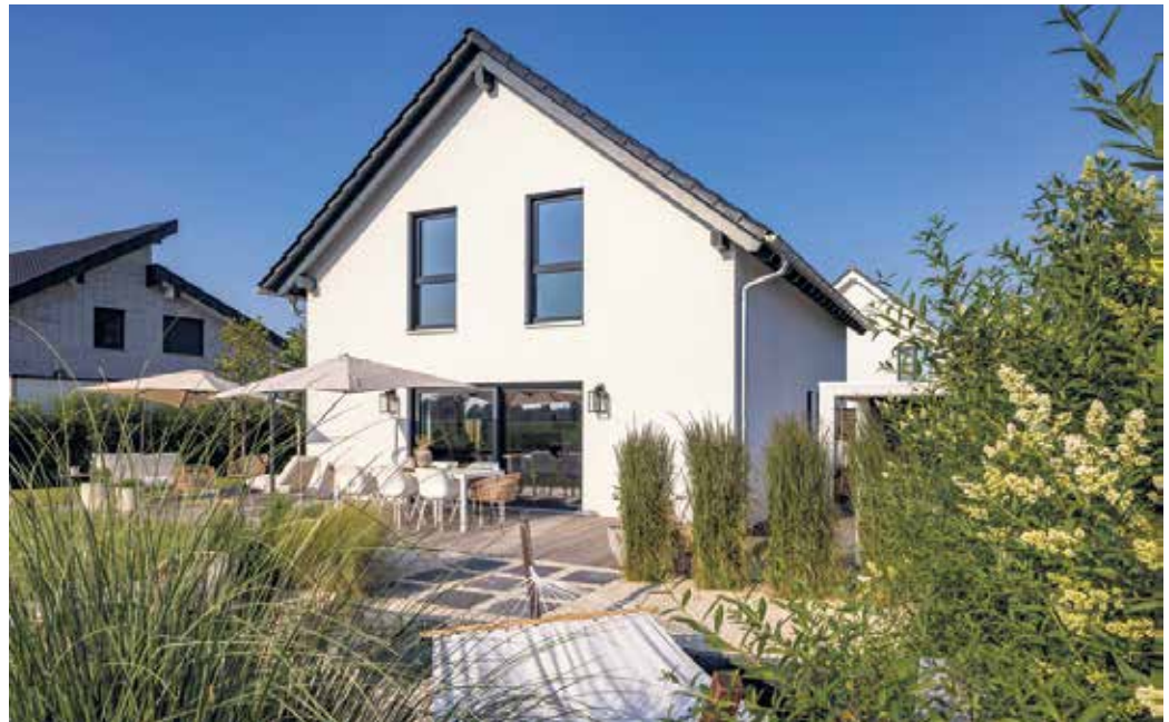
Mit dem nachwachsenden Rohstoff Holz aus nachhaltiger Forstwirtschaft und energieeffizienter Bauweise stehen Fertighäuser für zukunftsfähiges Wohnen. Foto: BDF/Fingerhaus
