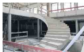
Gemeinsame Mitte - Verbindung zum Gebäude des HGN
