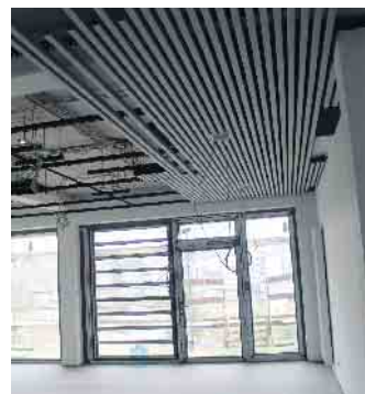
Differenzierungsraum mit bodentiefen Fenstern
