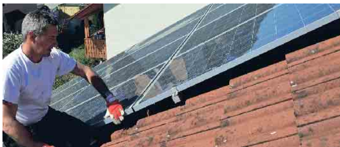
Der qualifizierte Dachdecker prüft die Befestigungen der Solarmodule und begutachtet die Unterkonstruktion im Rahmen des DachChecks. Foto: HF Redaktion/akz-o
