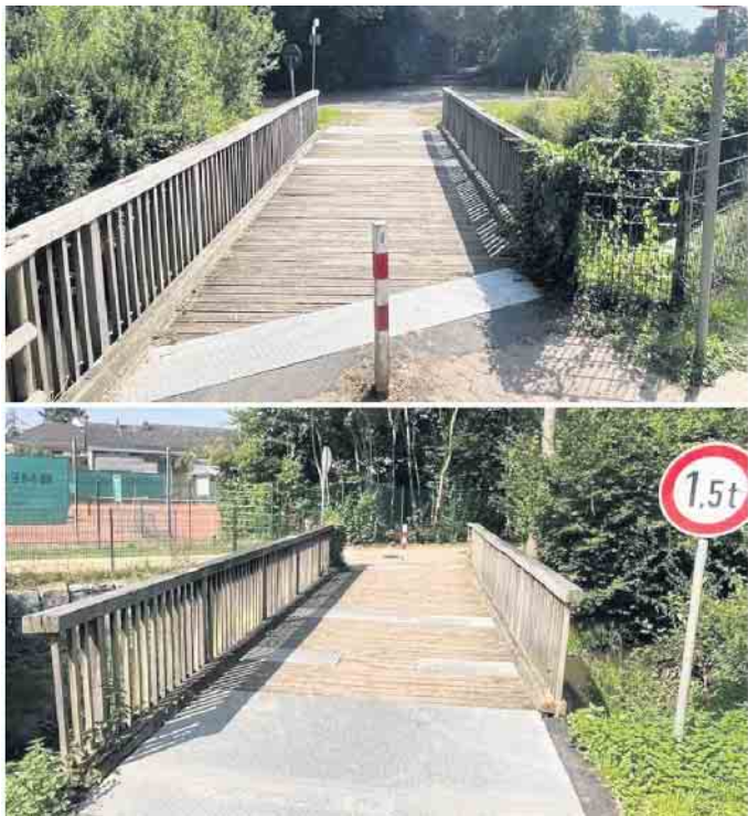
Neubau notwendig: Größere Schadstellen wurden in der Vergangenheit bereits mit Stahlplatten „geflickt“, um eine Sperrung zu vermeiden
