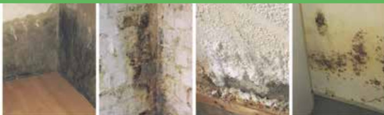
Defekte Horizontalsperre
