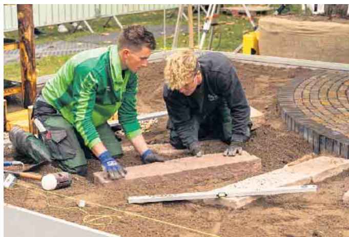
Bei der Verlegung von Trittstufen ist handwerkliches Geschick und Teamarbeit gefragt. Fotos: AuGaLa/Reidel
