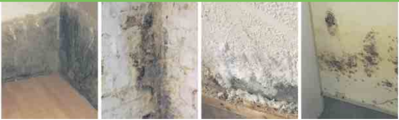
Defekte Horizontalsperre Querdurchfeuchtung Ausblühungen Schimmelbefall
