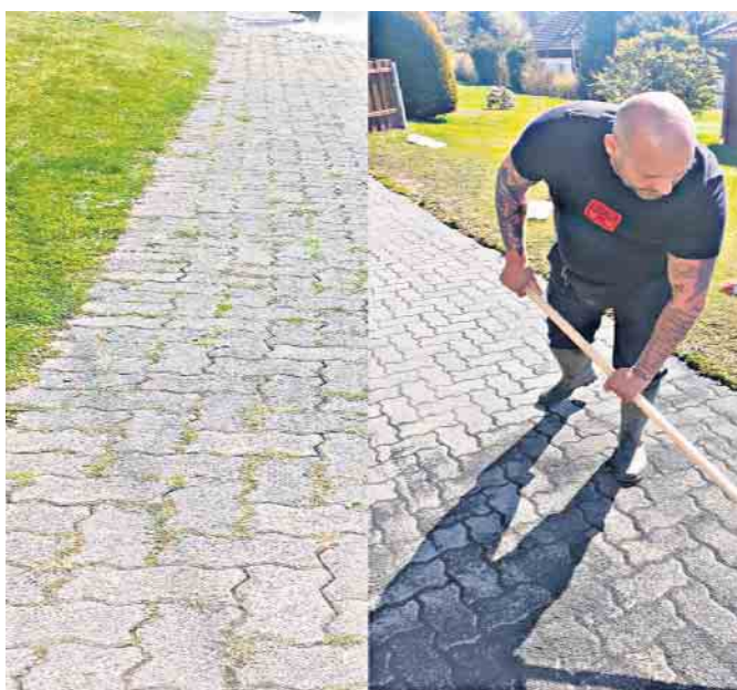
Reinigung von Fugen vorher und nachher.
