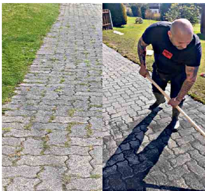
Reinigung von Fugen vorher und nachher.
