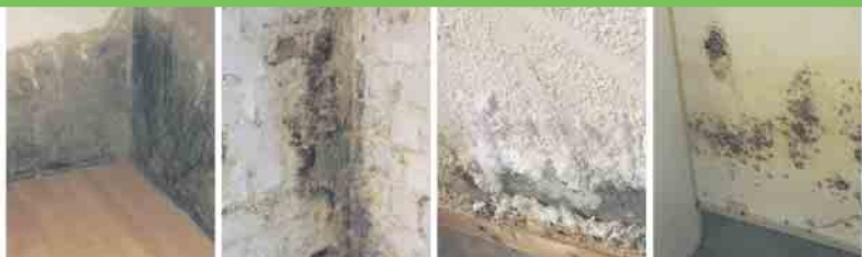
Defekte Horizontalsperre Querdurchfeuchtung Ausblühungen Schimmelbefall
