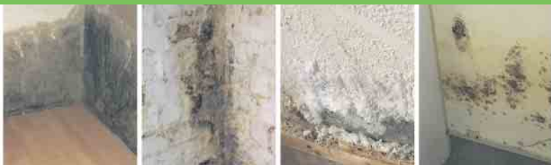
Defekte Horizontalsperre
