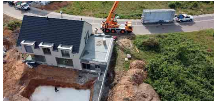
Per Kran wird das Becken eingesetzt. Foto: Vogel Pool/akz-o
