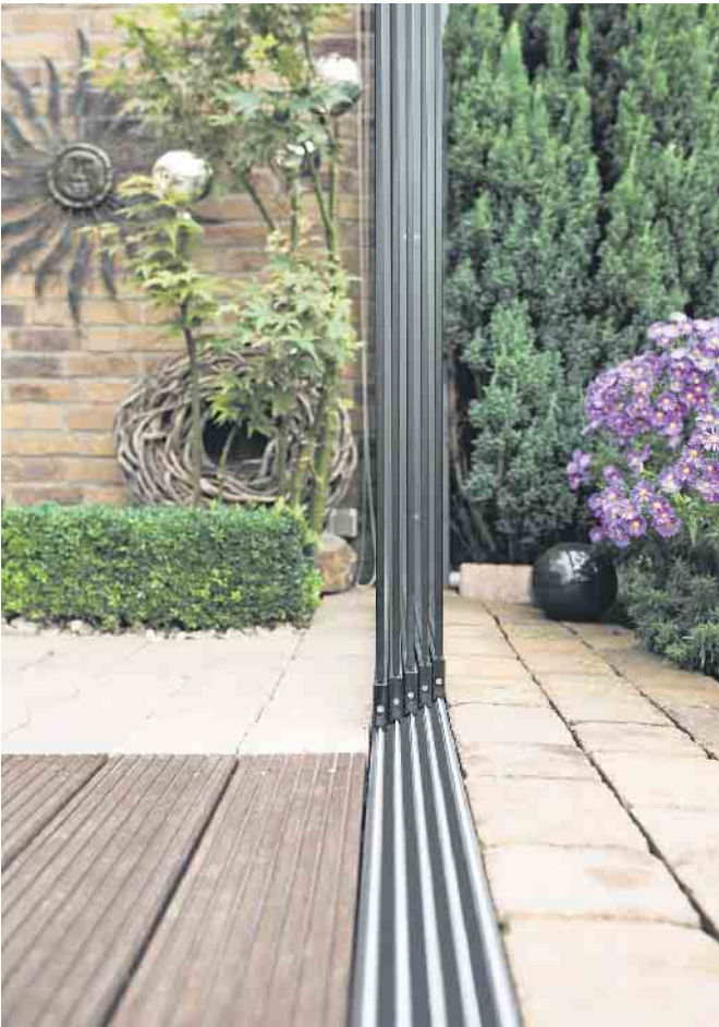
Ganzglas-Schiebeanlagen zeichnen sich durch eine besonders schlanke Konstruktion aus. Sie werden auf Laufschielen geführt. Foto: DJD/Bundesverband Wintergarten e.V.
