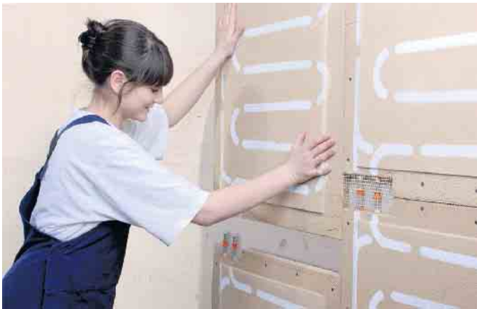
Eine angenehme und energiesparende Wandheizung ist mit Lehm-Plattenelementen, die ab Werk mit Heizungsrohren vorbestückt sind, schnell und einfach einzubauen. Foto: DJD/Naturbo
