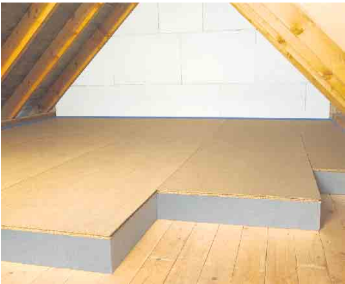
Eine professionelle Wärmedämmung verhindert, dass über den Dachboden kostspielige Heizenergie ungenutzt entweicht. Foto: djd/Brilllux Zuhause
