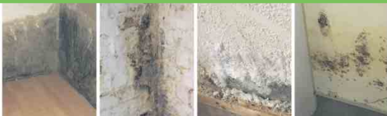
Defekte Horizontalsperre Querdurchfeuchtung Ausblühungen Schimmelbefall
