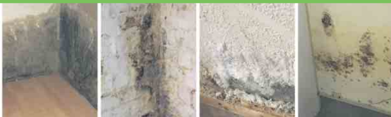
Defekte Horizontalsperre
