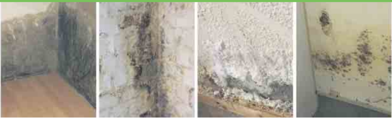
Defekte Horizontalsperre Querdurchfeuchtung Ausblühungen Schimmelbefall
