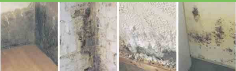
Defekte Horizontalsperre Querdurchfeuchtung Ausblühungen Schimmelbefall
