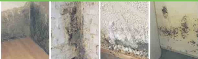
Defekte Horizontalsperre Querdurchfeuchtung Ausblühungen Schimmelbefall
