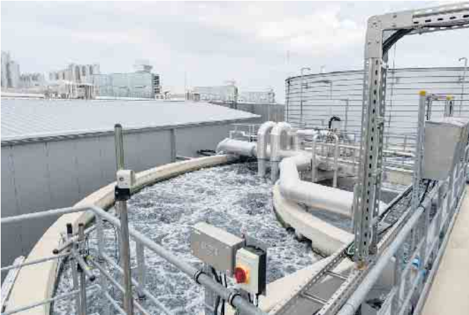
Blick in den Prozessbehälter der Hochwald-Kläranlage in Obergartzem. Gerüche werden an dieser Stelle des Klärprozesses durch die Wasserbläschen gebunden. An anderen Einrichtungen sollen Dunsthauben installiert werden. Foto: Ronald Larmann/pp/Agentur ProfiPress
