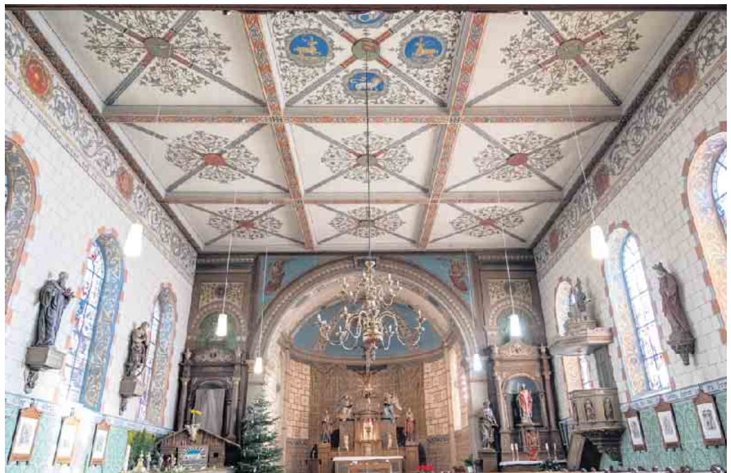
Die reich verzierte Holzdecke der Holzheimer Kirche St. Lambertus bereitet Sorgen. Durch Kondenswasser konnte sich der Hausschwamm ausbreiten und die Holzkonstruktion schädigen. Wegen Einsturzgefahr bleibt die Kirche bis auf Weiteres geschlossen. Foto: Ronald Larmann/pp/Agentur ProfiPress
