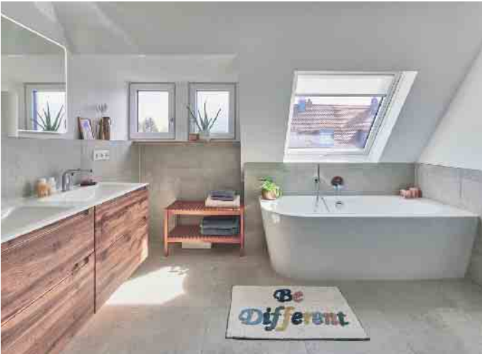
Dachfenster (rechts) und Gaube (links) in diesem Badezimmer zeigen den Unterschied: Während durch die Gaube mehr Wohnfläche mit voller Stehhöhe gewonnen wird, sorgt das Dachfenster für einen deutlich höheren Tageslichteinfall. Foto: Velux/Michael Christian Peters/akz-o
