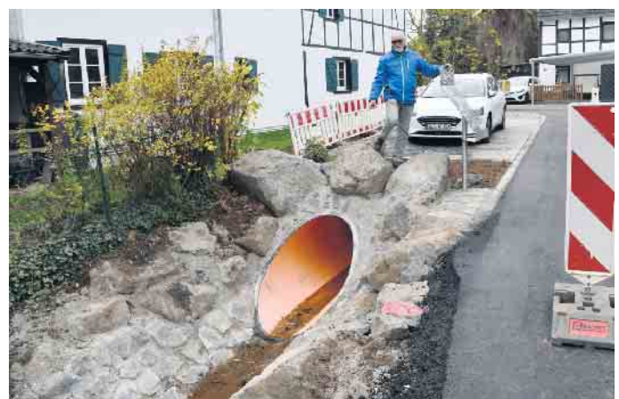
„In der Kumm“ kommt das auf 80 Zentimeter aufgeweitete Abflussrohr des Regenrückhaltebeckens erst hinter der Ortslage wieder zu Tage. Foto: Manfred Lang/pp/Agentur ProfiPress
