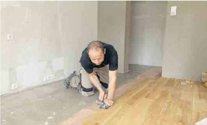
Ein Profi klebt die Eichendielen vollflächig auf den Untergrund. Das sichert eine gute Wärmeübertragung durch die Fußbodenheizung und sorgt für einen niedrigen Trittschall. Der eingesetzte Klebstoff trägt das Emicode-Zeichen EC 1. Dieses Siegel gewährleistet geringste Emissionen und schont die Gesundheit der Verarbeiter und Bewohner. Foto: Initiative Parkett im Klebeverbund (PIK)
