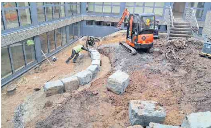
Mit Hilfe des Baggers ordneten die Mitarbeiter der Firma Glasmacher die Natursteine im Halbrund an und modellierten das Gelände. Foto: privat/pp/Agentur ProfiPress
