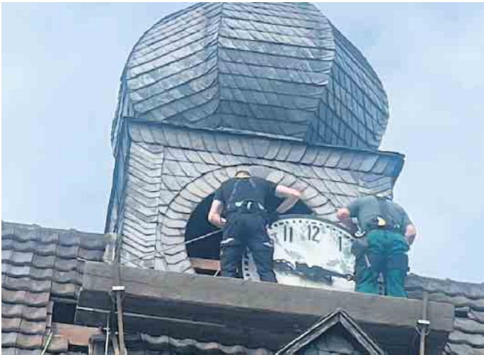
Um das historische Kleinod zu restaurieren, demontierten Turmuhrbeauftragter Udo Küpper, sein Sohn Martin und die Junggesellen zunächst das Zifferblatt. Foto: Hermann-Josef Krest/pp/Agentur ProfiPress
