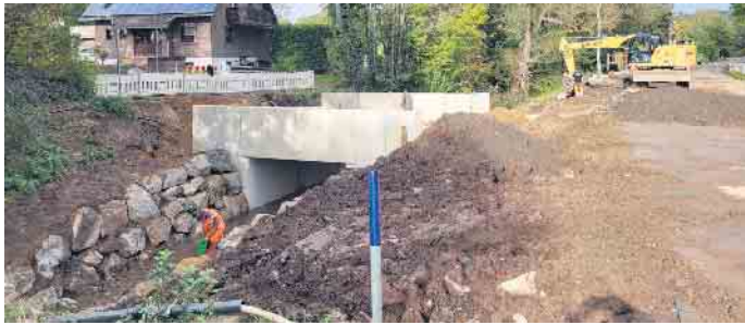
Per erprobter Fertigbauweise wird derzeit eine neue Brücke errichtet, die ab Dezember in Betrieb gehen soll. Foto: Manfred Lang/pp/Agentur ProfiPress
