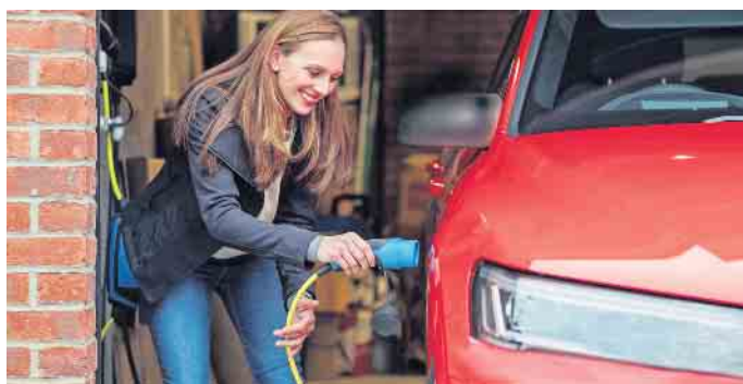
Strom aus der eigenen Garage: Immer mehr Fahrerinnen und Fahrer eines E-Autos lassen sich eine private Wallbox installieren.
