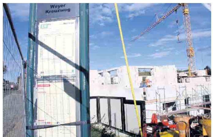
An der Weyerer Hauptstraße liegt der Neubau, in dem das abgeschlossene Erdgeschoss für die Wohngruppe der vier Autisten entsteht. Foto: Steffi Tucholke/pp/Agentur ProfiPress
