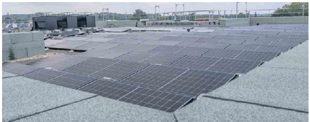
Das Dach des Schmetterlings ist voller Solarpaneele, um Gebäude und Wärmepumpen mit Sonnenstrom zu versorgen. Foto: Ronald Larmann/pp/Agentur ProfiPress
