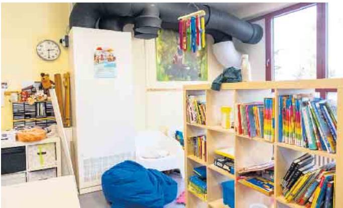
An zwölf Stellen war eine Deckeninstallation aus baulichen Gründen nicht möglich. Die Standgeräte verfügen allerdings nicht über eine Kühlfunktion. Foto: Ronald Larmann/pp/Agentur ProfiPress
