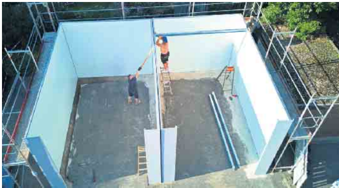
Errichtet wurde das moderne Steck- und Schraubsystem aus vorgefertigten Teilen per Muskelkraft.
