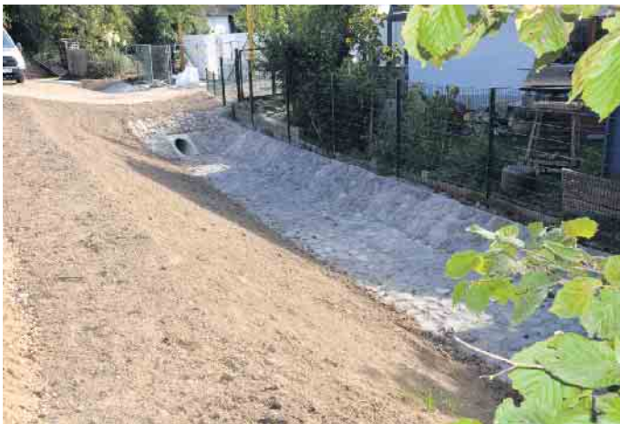
Oberflächenwasser aus dem Ort kann nun schnell durch insgesamt vier Durchlässe im Damm... Foto: Henri Grüger/pp/Agentur ProfiPress
