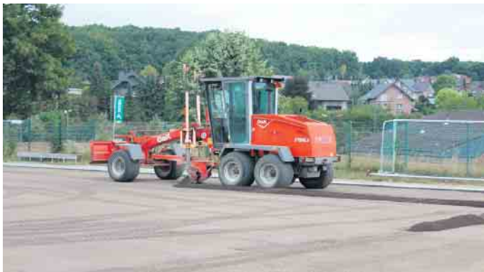
Mit dem Grader wird aktuell eine feine Lavaschicht eingeebnet. Auf sie kommt die elastische Tragschicht, die den Kunstrasen hält. Damit er nicht verrutscht, werden pro Quadratmeter 25 Kilogramm Sand verteilt. Foto: Kerstin Rottland/pp/ProfiPress
