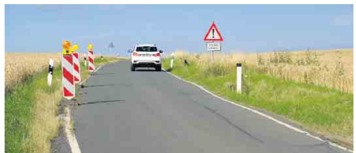
Die Kreisstraße 58 zwischen Harzheim und Eiserfey befindet sich in einem schlechten Zustand. Im Rahmen der Sanierungsarbeiten soll die Straße auch auf eine Breite von sechs Metern erweitert werden. Foto: Thorsten Wirtz/RRG/pp/Agentur ProfiPress
