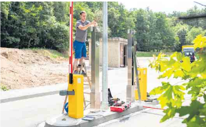
Die Schrankenanlage steht: Simon Hilgers von der Mechernicher Firma Elektro Braun arbeitet an einer der Säulen. Foto: Ronald Larmann/pp/Agentur ProfiPress
