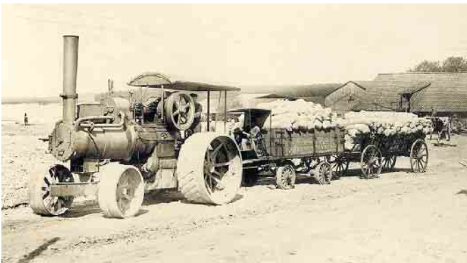
Um 1900 schafften sich die Girards ein Dampflokomobil an, um benötigte Materialien vom und zum Mechernicher Bahnhof zu transportieren. Später wurde dieses auch als Dampf-Straßenwalze genutzt. Archivbild: Wilhelm Mausbach/Verein zur Förderung und Erhaltung der Werkzeugmaschinenbautradition in der Eifel/pp/Agentur ProfiPress
