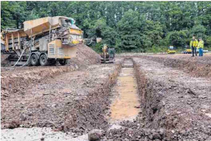
Dieser Graben nimmt den Dammsporn auf, der ein Unterspülen des Bauwerks verhindern soll. In der Mitte ist das Rohr des Odensiefen zu sehen, der im Zuge der Maßnahme wieder freigelegt wird. Foto: Ronald Larmann/pp/Agentur ProfiPress
