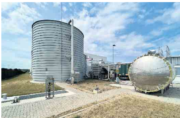
Nur mit Gittern bedeckt sind derzeit die zwei Schächte vorne links und rechts neben dem Stahltank, in denen das zu klärende Wasser ankommt. Auch hier werden Abdeckungen installiert, um auftretende Gerüche zu bändigen.
