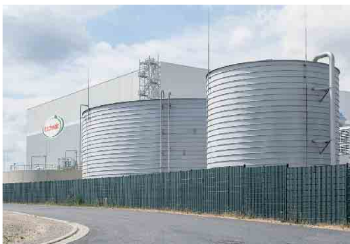
Um den neun Meter hohen Misch- und Ausgleichsbehälter (I.) mit einer Abdeckung zu versehen, braucht es statische Ertüchtigungen. Die Luft unter den Hauben wird künftig abgesaugt und über Biofilter gereinigt, so dass Geruchsemissionen der Vergangenheit angehören sollten.
