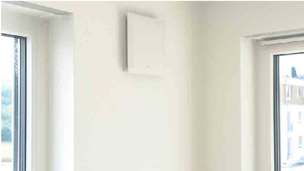
Der bedarfsgeführte Luftwechsel über eine Lüftungsanlage verhindert eine sogenannte Überfeuchtung der Räume und verbessert die Luftqualität. Foto: djd/BDH
