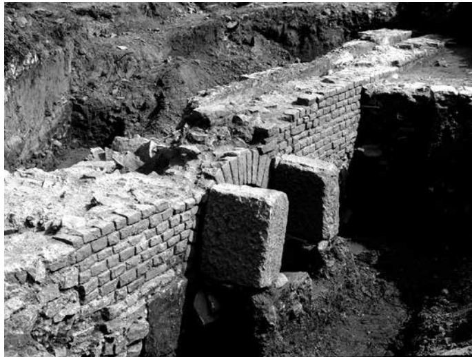
Die römische Aquäduktbrücke in Mechernich-Vollem/Urfey ist eine der Stationen der geführten Wanderung.
