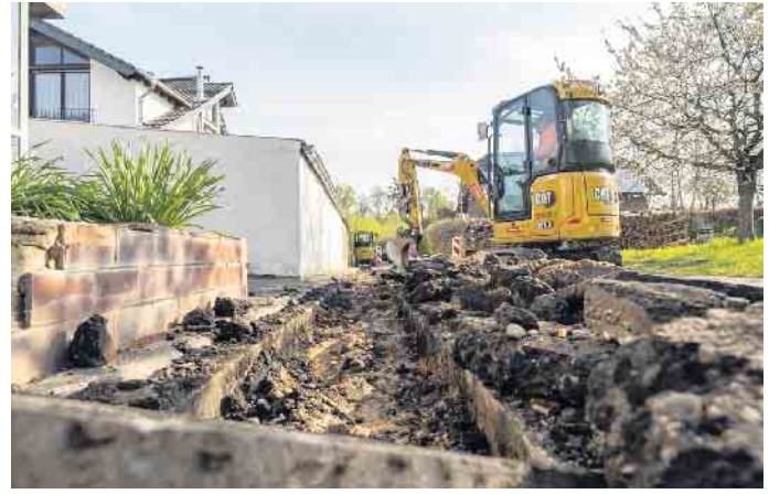
Mit Mini-Bagger sind die Mitarbeiter der Firma iMV bereits seit einigen Wochen dabei, in Satzvey Glasfaserkabel zu verlegen. Foto: Ronald Larmann/pp/Agentur ProfiPress
