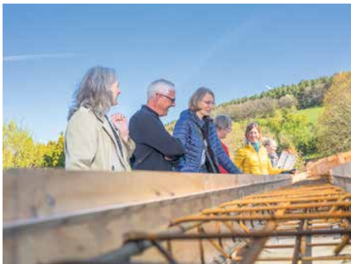
Gute Laune auf dem Gerüst: Denkmalschützerin Janine Deinzer (v.l.), Bauherr Peter Ratz und Landeskonservatorin Dr. Andrea Pufke begutachten den Ringanker, der für den Ausbau des Turms benötigt wird. Foto: Ronald Larmann/pp/Agentur ProfiPress
