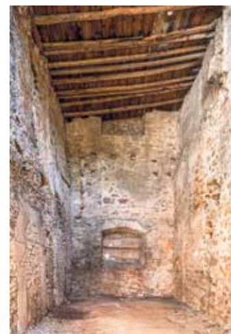
Der Hallencharakter lässt sich hier erahnen. Links oben ist zu sehen, wie sich die „Knäcke-brotwand“ ordentlich zur Seite neigt. Foto: Team Bauforschung, LVR-Amt für Denkmalpflege im Rheinland/pp/Agentur ProfiPress
