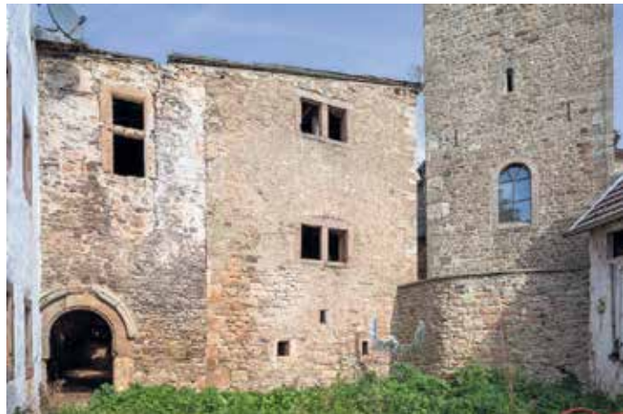
Das war der Zustand vor der Sanierung: Das Gebäude der Burg Kallmuth grenzt direkt an die Kirche an und wird aktuell aus dem Dornröschenschlaf geweckt. Foto: Team Bauforschung, LVR-Amt für Denkmalpflege im Rheinland/pp/Agentur ProfiPress
