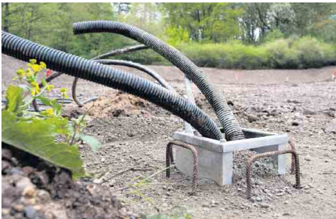
Die Leerrohre liegen, das Fundament ist gegossen: An diesen Stellen werden in den nächsten Wochen die Stromsäulen montiert. Foto: Ronald Larmann/pp/Agentur ProfiPress
