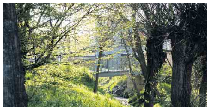
Die Fußgängerbrücke am Ende des Bahnhofswegs erzeugt eine künstliche Engstelle. Hier soll die Böschung abgetragen werden, damit mehr Wasser abfließen kann. Foto: Ronald Larmann/pp/Agentur ProfiPress
