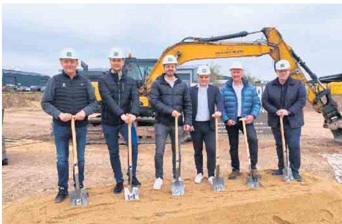
Fünf Spaten standen bereit: Jeweils einer für Erich Meiser, (Firma Heim Bau), Bürgermeister Michael Fingel, Christian Habrich (Team Wirtschaftsförderung, Stadt Mechernich), Mats Riepenhausen, Jörg Welleshauser (Bauprojektleiter, McDonald's) und Peter Schürger (Abteilung Operation, McDonald's). Foto: Kerstin Rottland/pp/Agentur ProfiPress
