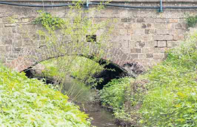
Ausgeschwemmte Fugen, fehlende und lose Steine: Die Brücke in der Roggendorfer Johann-Baptist-Straße hat in der Flut ordentlich einen mitbekommen. Sie wird im Sommer abgerissen und erneuert.
