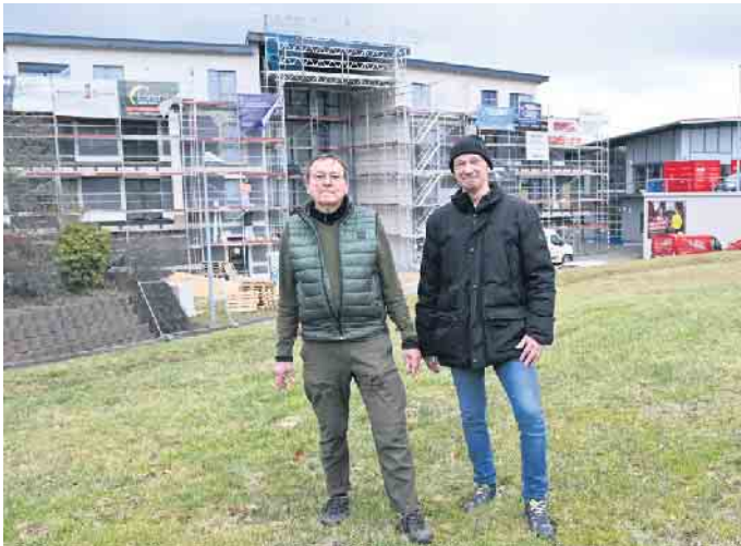
Rolf Schäfer (l.) und Guido Bauer vor der im Bau befindlichen „Heimatpassage“ an der Bruchgasse. Direkt angrenzend: das Fitnesscenter „Clever Fit“, ebenfalls ein Projekt der beiden Mechnicher Unternehmer. Foto: Manfred Lang/pp/Agentur ProfiPress
